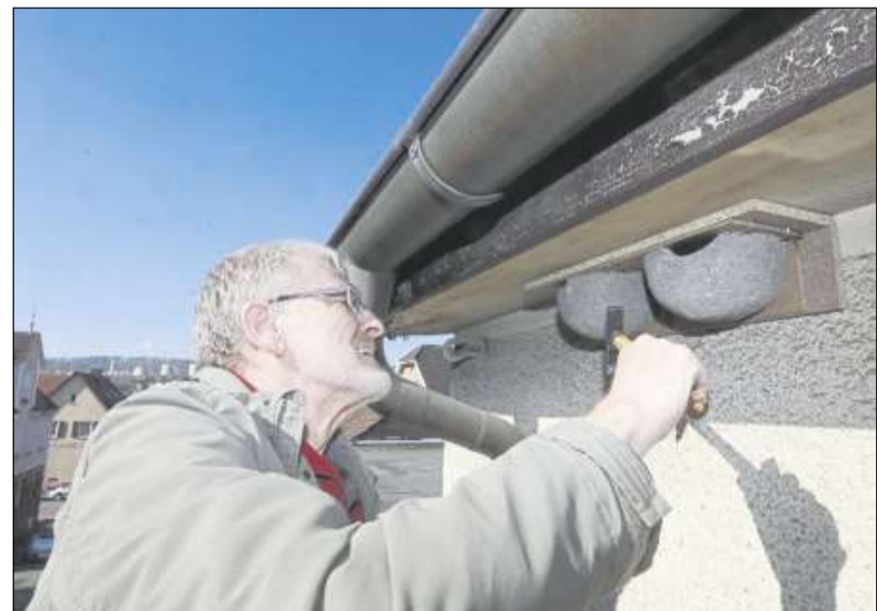
William Patrick montiert vom Hubsteiger aus die Nester direkt am Dachtrauf.
